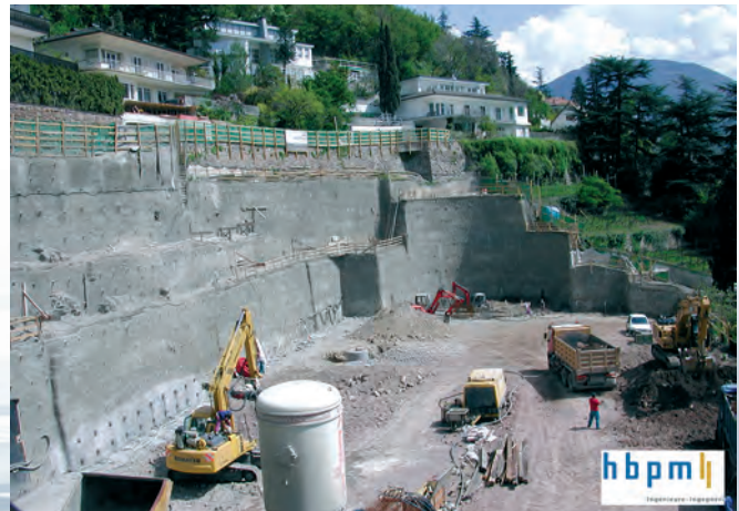
Berechnet mit DC-Software Mehrstufige Nagelwand in Bozen
