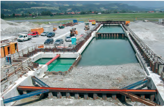
Berechnet mit DC-Software Spundwände am Brenner-Basistunnel (Brixlegg)
